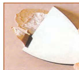
الف - باز کردن ترک‌ها
