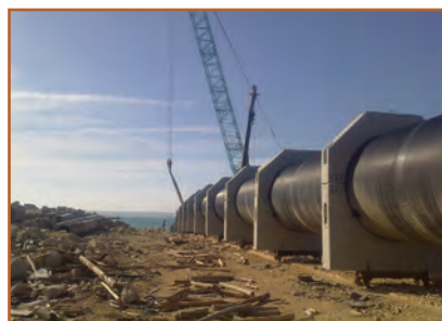
ت - احداث خطوط لوله
