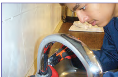
خ- سوار کردن اجزای باز شده
