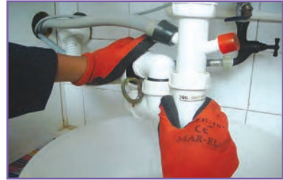
الف- قراردادن ظرف زیر سیفون و باز کردن آن
