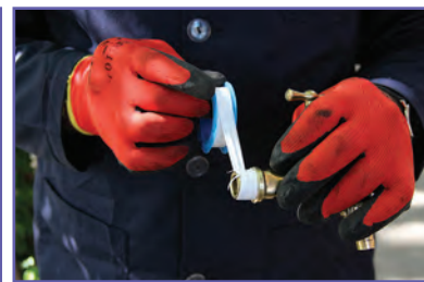
پ- پیچیدن نوار تفلون روی شیر نو
