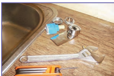
ح- اطمینان از سالم بودن قطعات و تعویض مغزی
