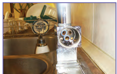
ج- کنترل نشیمنگاه
