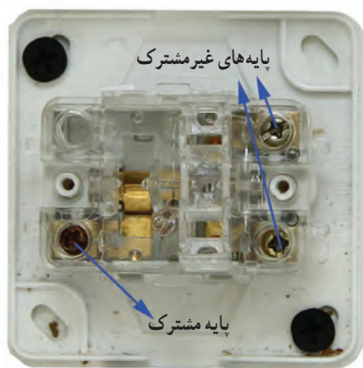
شکل ۱۹-۵- نمای داخلی یک نمونه کلید تبدیل
