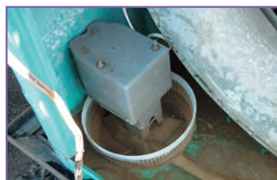
ج- بررسی و تمیز کردن پمپ آب
