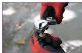
ج - جایگزینی واشر آب بندی و سفت کردن آن
