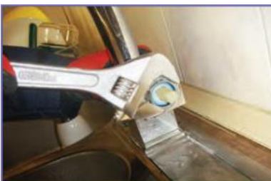
ث- باز کردن پیچ روی مغزی (گلند)
