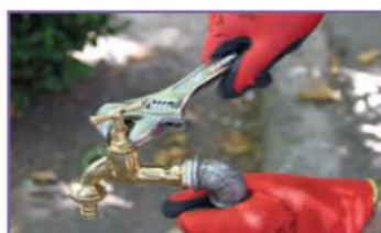
ج - بستن کلگی شیر ابتدا با دست و سپس محکم کردن آن با آچار
