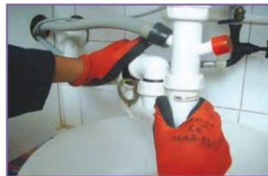
الف- قراردادن ظرف زیر سیفون و باز کردن آن
