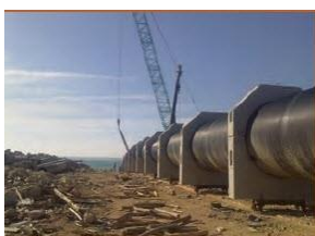
ت - احداث خطوط لوله
