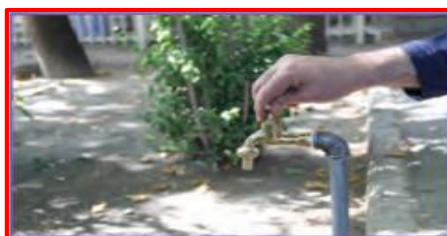
خ - آزمایش آب بندی شیر
