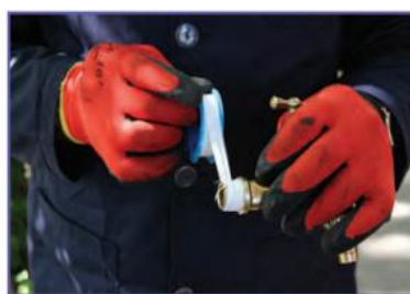
ب- پیچیدن نوار تفلون روی شیر نو
