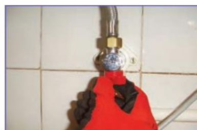
الف- بستن شیرهای آب گرم و سرد پیسوار زیر کاسه
