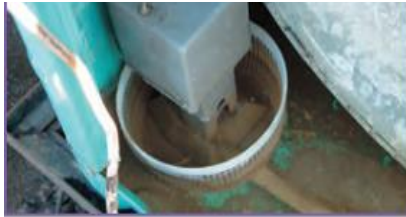
ج- بررسی و تمیز کردن پمپ آب
