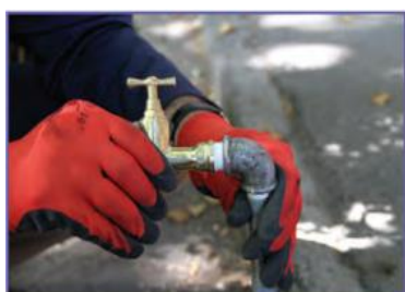
ت- بستن شیر با دست به لوله
