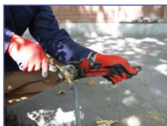
ب- باز کردن شیر با دو آچار
